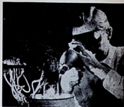
Thermionische omzetter, een ontwikkeling van R.C.A. De thermionische generator zet warmte direct om in elektrische energie.
